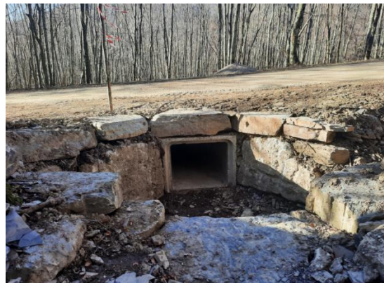
Ripristino dell'ufficiosità idraulica del fosso del Chiodo a Bedonia.
