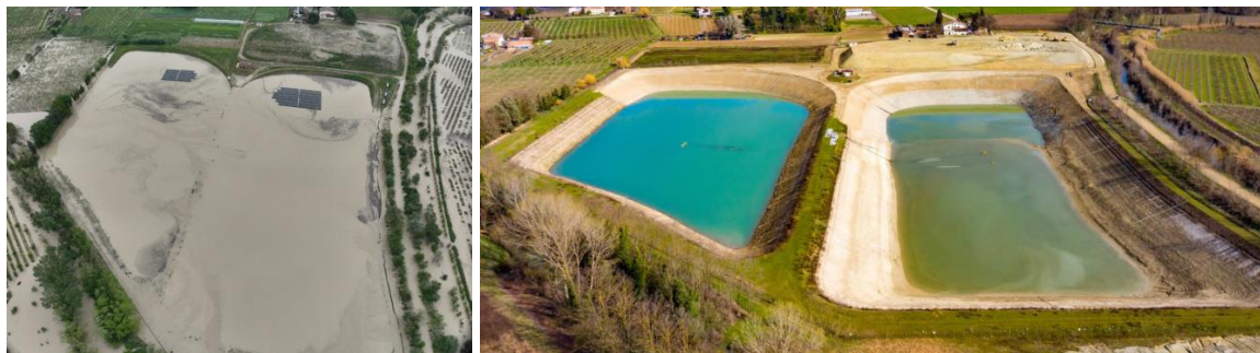
Ripristino di due laghetti interconsortili danneggiati durante l'evento di piena di maggio 2023. Prima (sx) dopo (dx)
