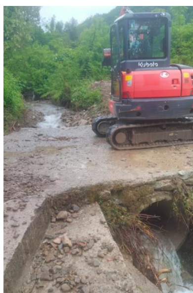
Rimozione dell'ostruzione a monte di uno scatolare nel Rio Faie a Castel D'Aiano, (a) prima e (b) dopo
