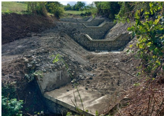
Ripristino di briglie in pietrame in Località Ragalli, Bobbio
