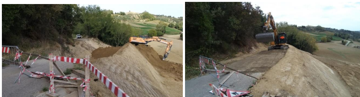
Ripristino frana su strada (prima e in corso dei lavori). Prima (sx) dopo (dx)
