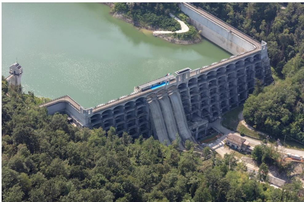
**Realizzazione vasca di impatto getti e successiva vasca di dissipazione con consolidamento versanti a valle dello scarico di superficie in corpo diga.**
