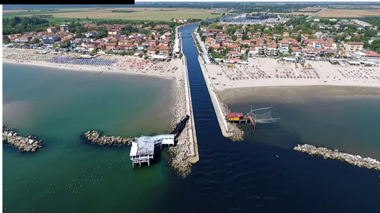
Canale Destra Reno
