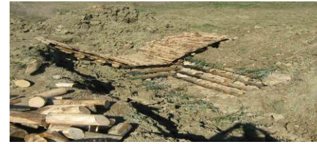
CANTIERI DI INGEGNERIA NATURALISTICA
