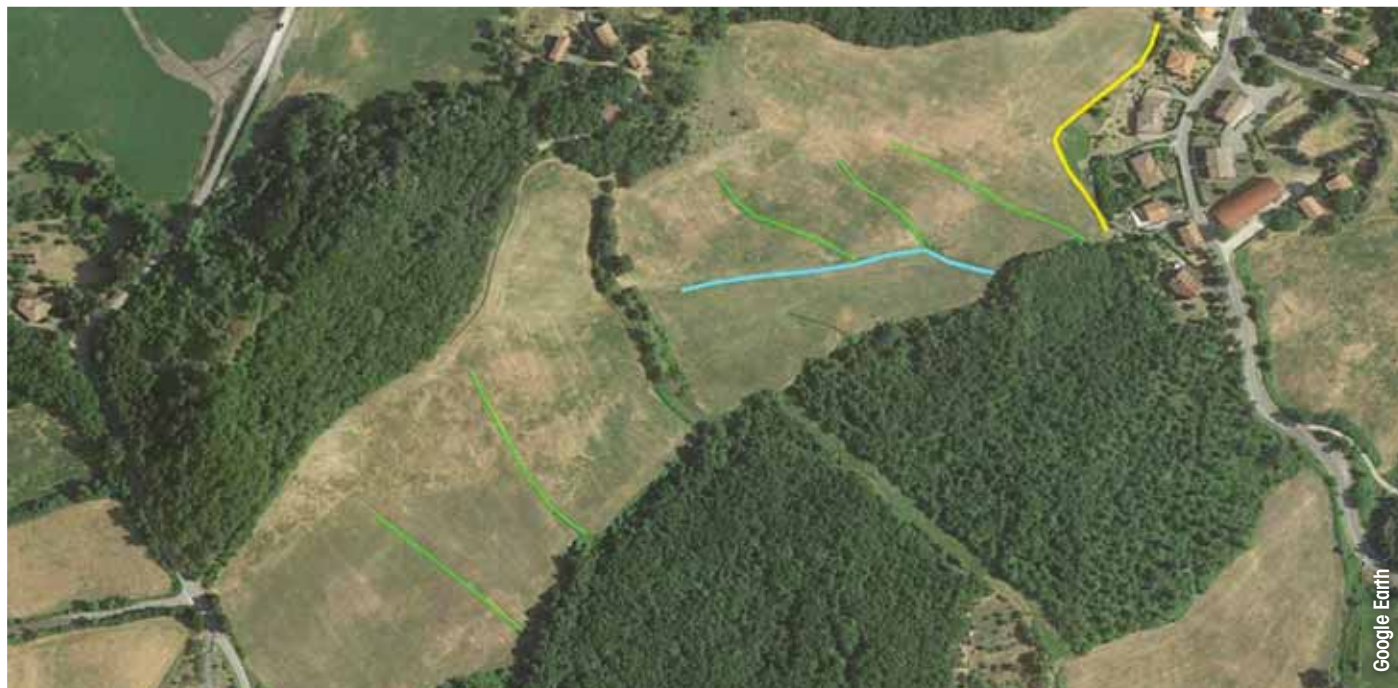
Ripresa aerea con evidenziati in azzurro il collettore primario ripristinato, in verde le fosse livellari e in giallo il fosso di valle (regimazione idraulico-agraria permanente)
