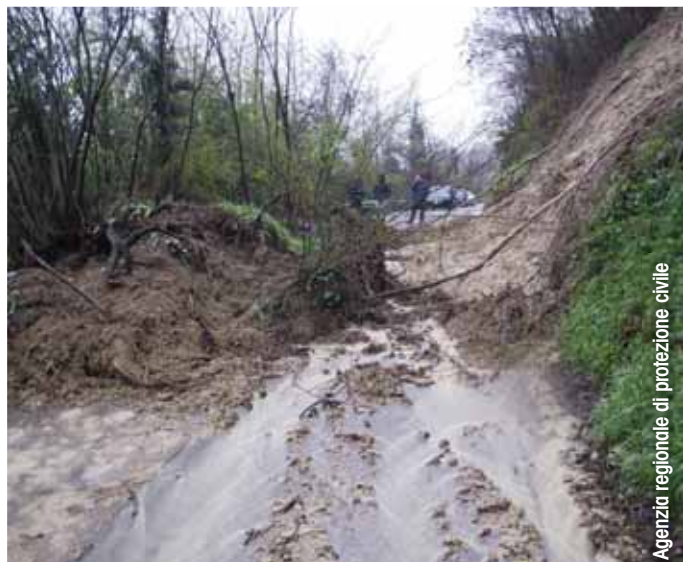
Frana di tipo B con interruzione completa del transito per invasione di terra e detriti dalla scarpata di monte. Comune di Bologna, località Colli, marzo-aprile 2013
