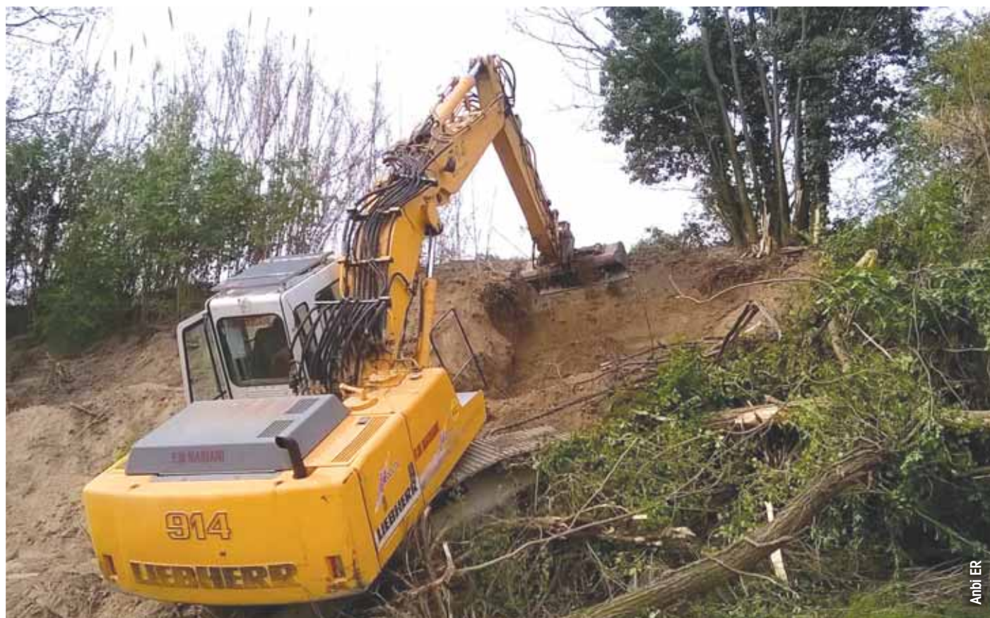
Sistemazione di una scarpata interessata da fenomeni di dissesto - Consorzio di bonifica Romagna occidentale
