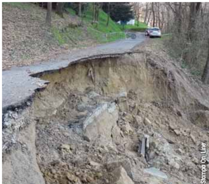
Frana di tipo C con interruzione totale della viabilità. Comune di Monzuno, località Vado (Bo), febbraio-marzo 2014
