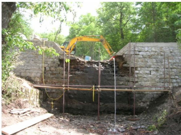
Ripristino opere idrauliche di bonifica
