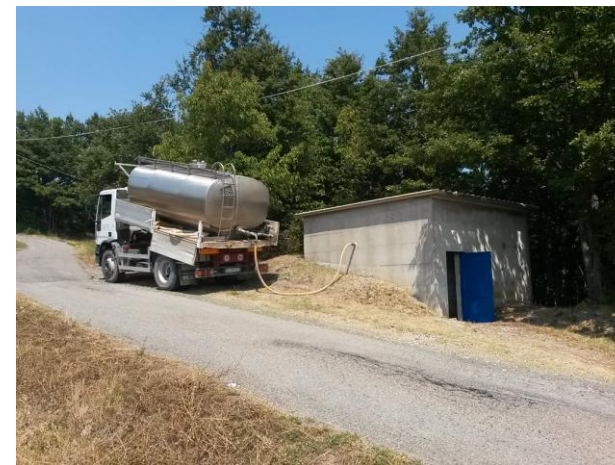
Acquedotti di bonifica
