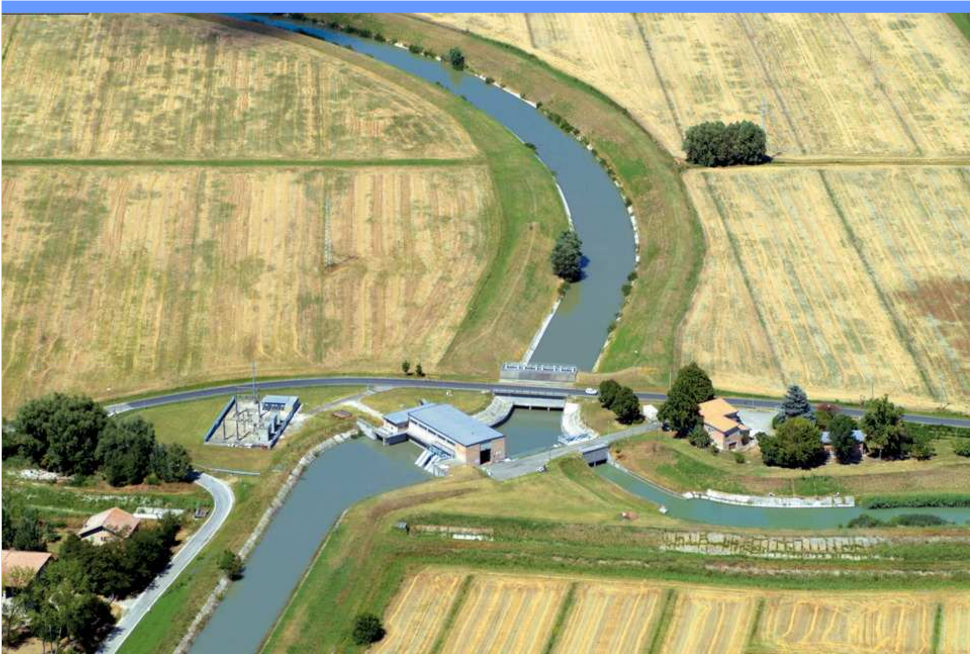
IMPIANTO IDROVORO CREVENZOSA
