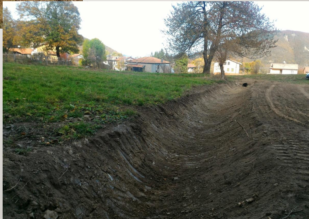
REGIMAZIONE ACQUE SUPERFICIALI: LOCALITÀ ROMITA IN COMUNE DI VILLA MINOZZO
