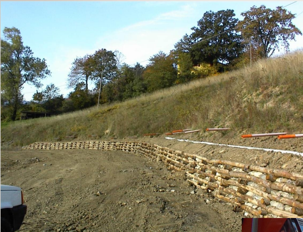
Drenaggi suborizzontali e palificata doppia in pietrame e legname
